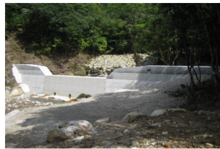
継続した谷止工の設置
