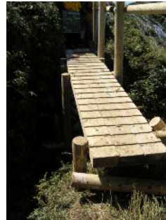
植生等回復措置 (木橋型歩道工)
