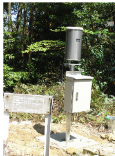
雨量計(宮之浦林道)
