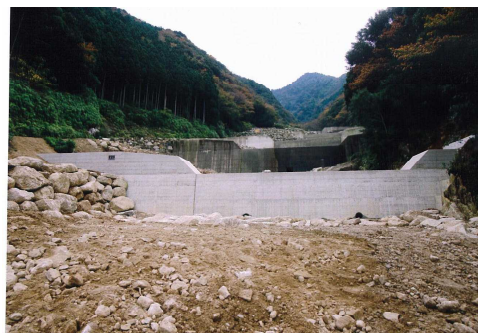
コンクリート谷止工 (屋久島町平瀬国有林)
