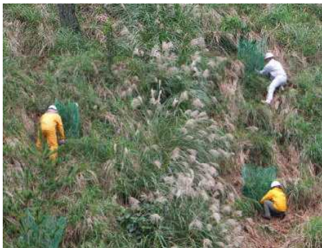
下刈及びシカネットの補修作業
