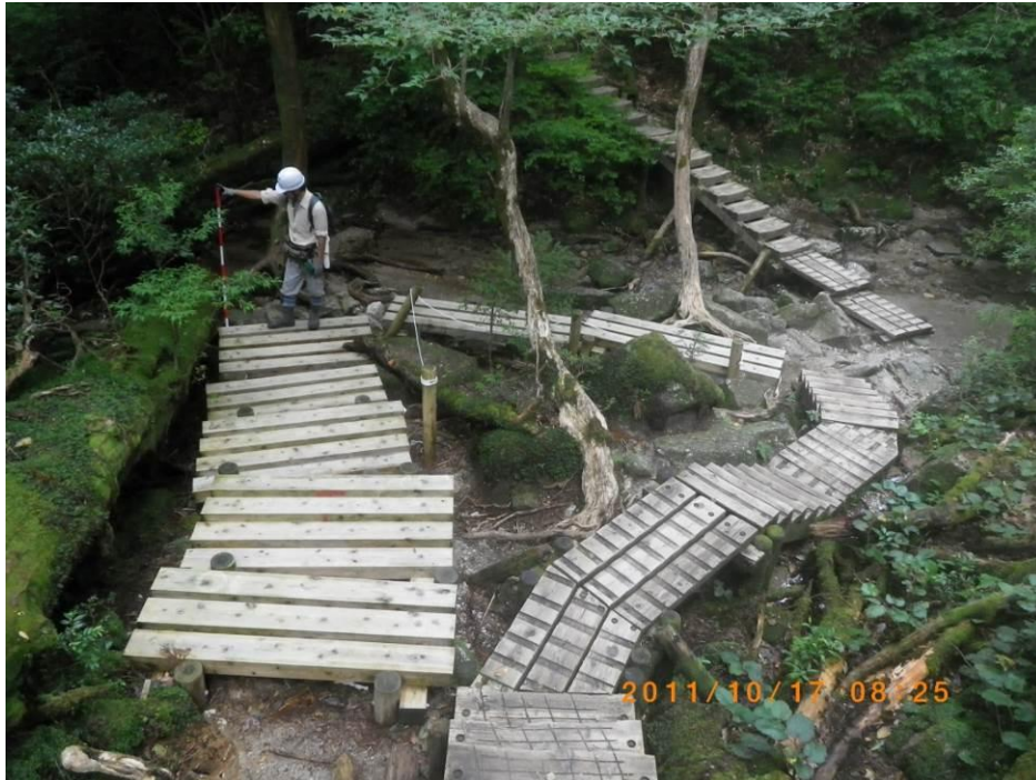
写真－１－１ 対策実施状況（No.3 箇所事例〔計画図は図-2-1 参照〕）
