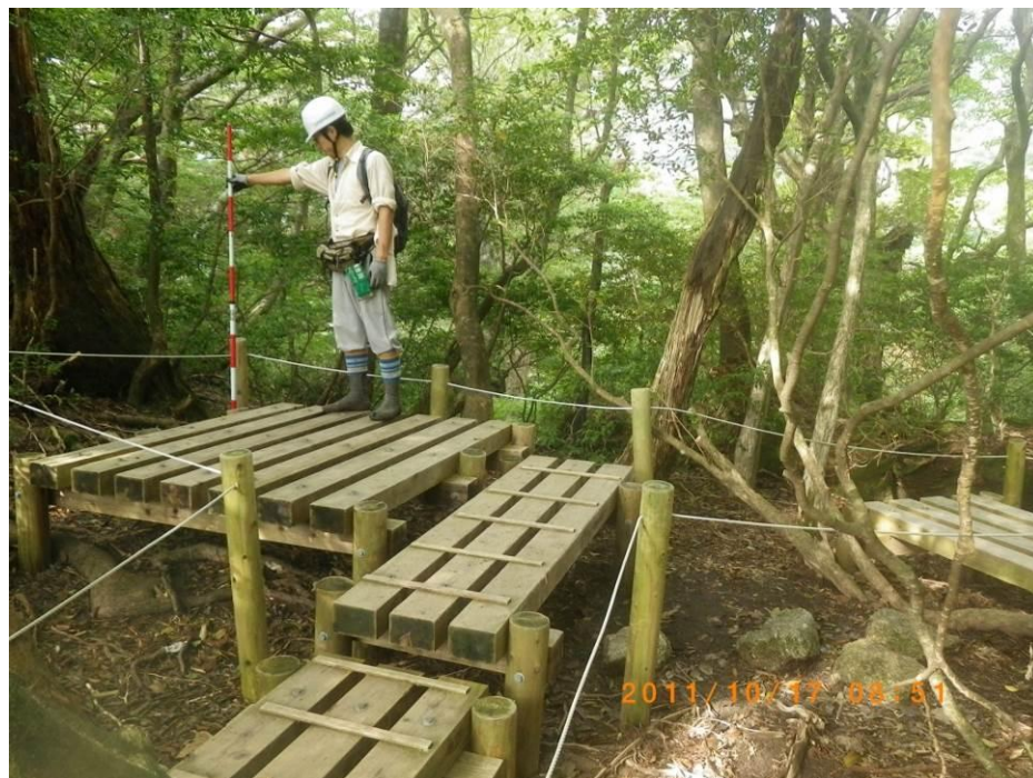
写真－１－２ 対策実施状況（No.3 箇所事例〔計画図は図-2-2 参照〕）
