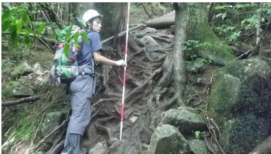
写真－２－３ No.13 の荒廃状況 (H24)
