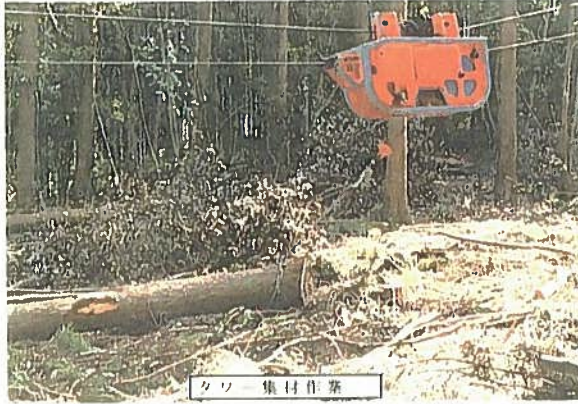
クロー集材作業
