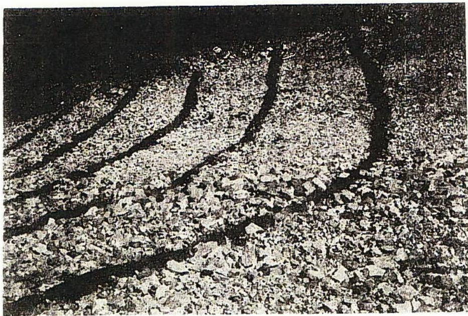
植生土のう筋工
