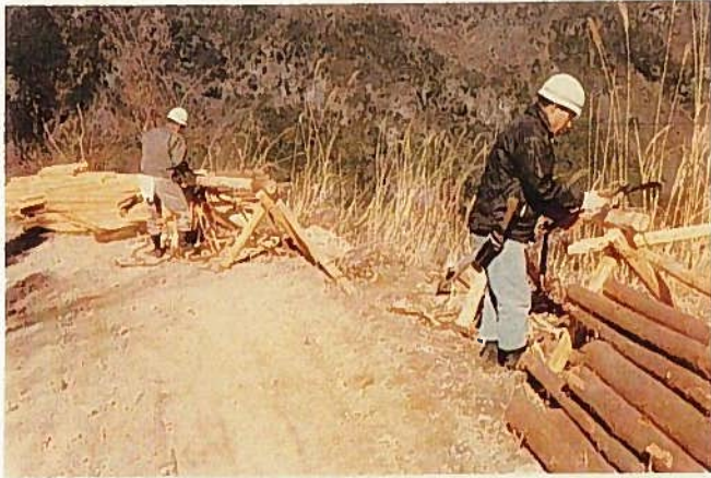
頭材(同伐材)の製作
