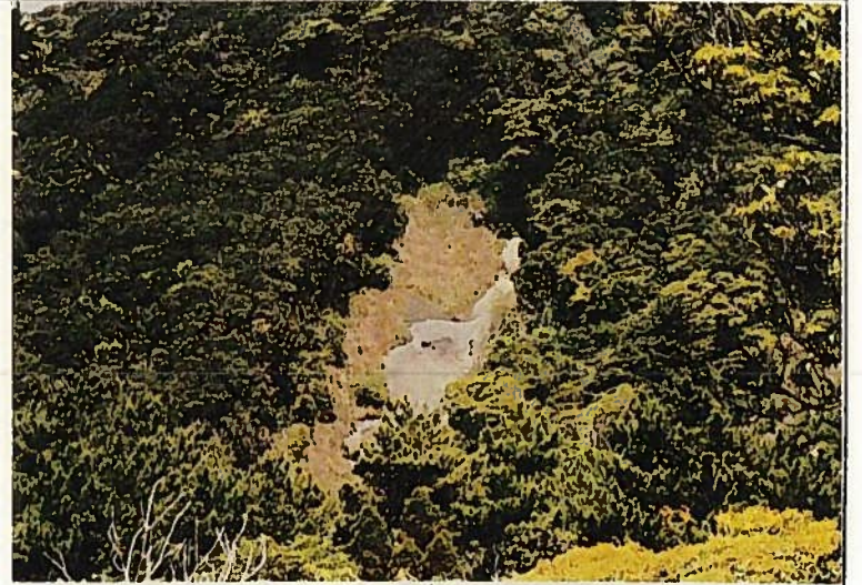
中津野川 全景 山腹工 モルタル面
