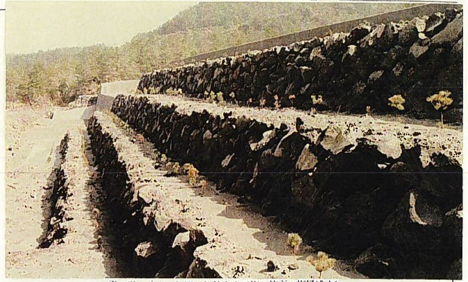
引の平 (コンクリート谷止め工施工箇所の修景盛土)
