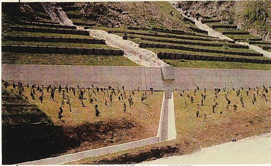
官迫沢 (木柵工とクロマツ植栽状況)
