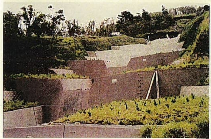
深谷川第2支溪(カラセラ吹付)
