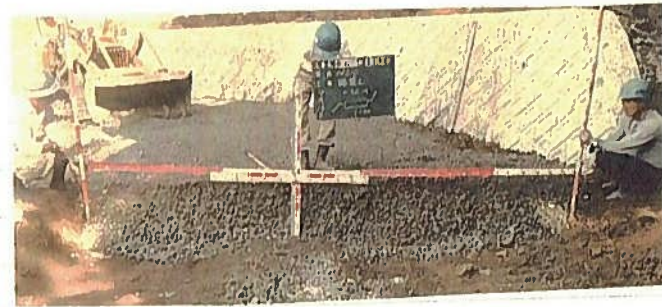
排水工法 敷厚 0.4m
