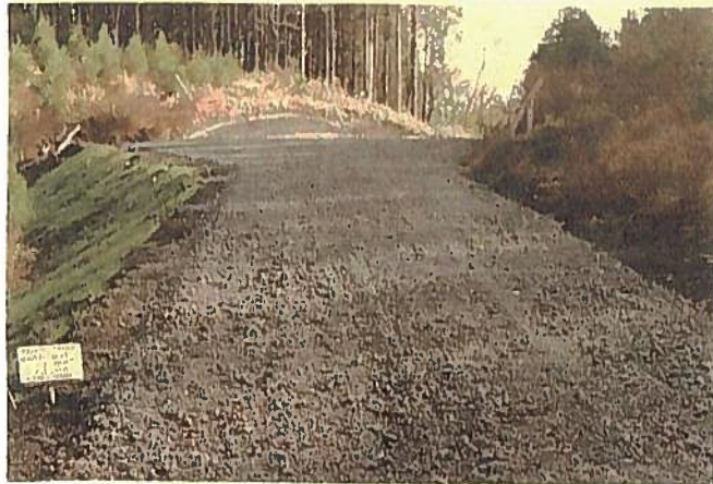
盲溝築工法 完成 敷厚 0.2m
