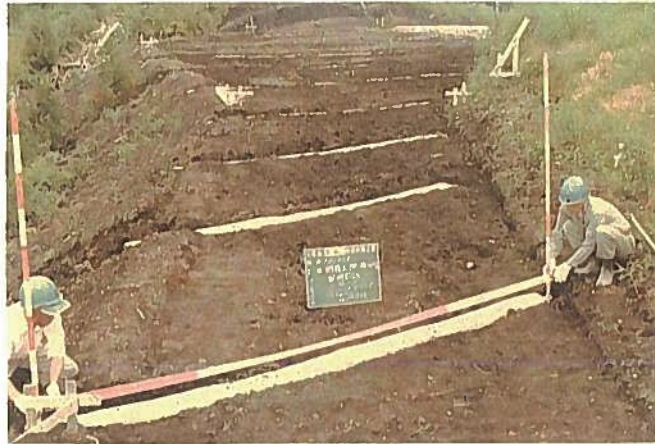
盲溝築工法 へび口ロ-ン布設
