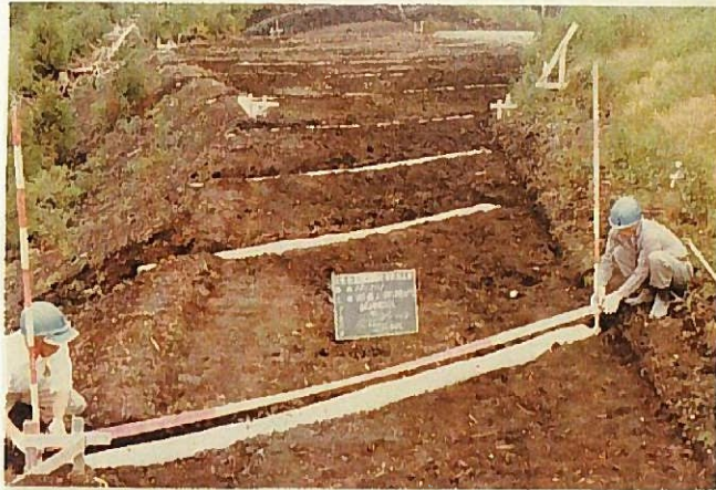
盲 隆 渠 工 法 八 十 二 ロ ン 布 設
