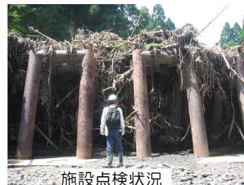
施設点検状況
