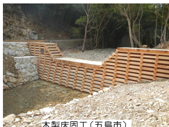
木製床固工（五島市）
