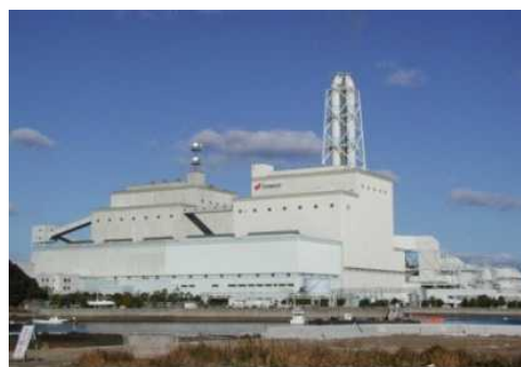
発電所における木質混焼 (木質チップ・ペレット)
