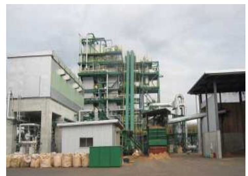
木質バイオマス発電施設(大分県日田市)
