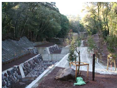
平成25年度集之浦地区（宮崎県小林市） 【流路工の壁面に現地で発生した土石を使用】
