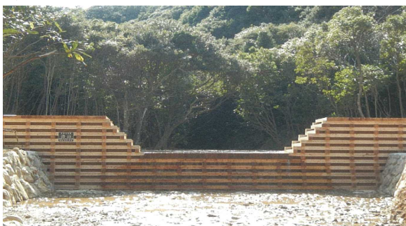
平成25年度川原地区（長崎県五島市） 【木製床固工：木材使用量44.8m 3 】
