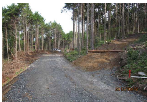
林業専用道と森林作業道の組み合わせによる効率的な森林整備
