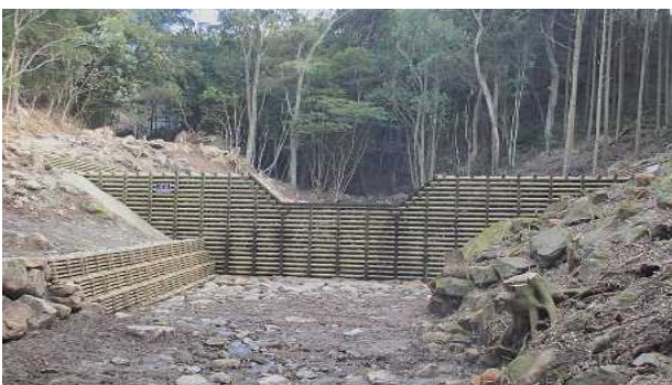
平成26年度 木製床固工（鹿児島県出水市） 【木材使用量 29m 3 】
