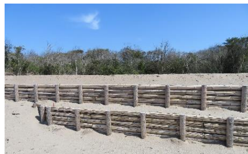
竹製柵工による海岸保安林の整備（鹿児島県日置市）
