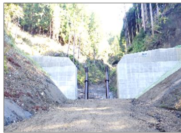
流木捕捉式治山ダムの設置
