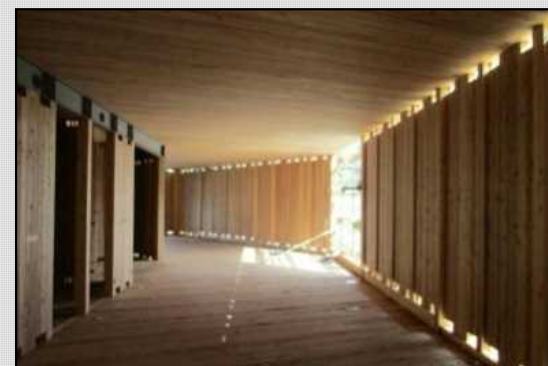
ウッドエナジーのCLTオフィスで見学会(H28. 1月)
