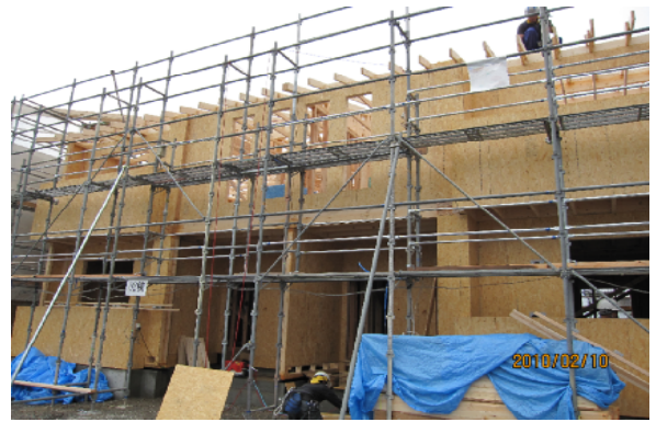
建設中の2×4住宅
