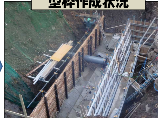
型枠作成状況
