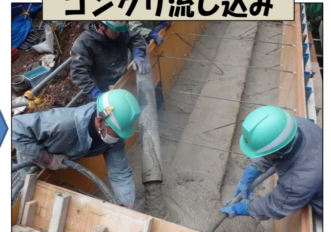
コンクリ流し込み
