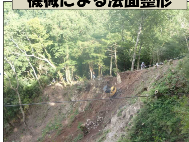
機械による法面整形
