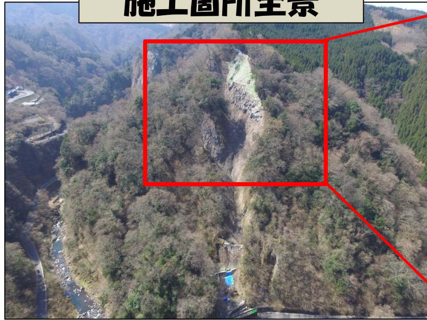
施工箇所全景
