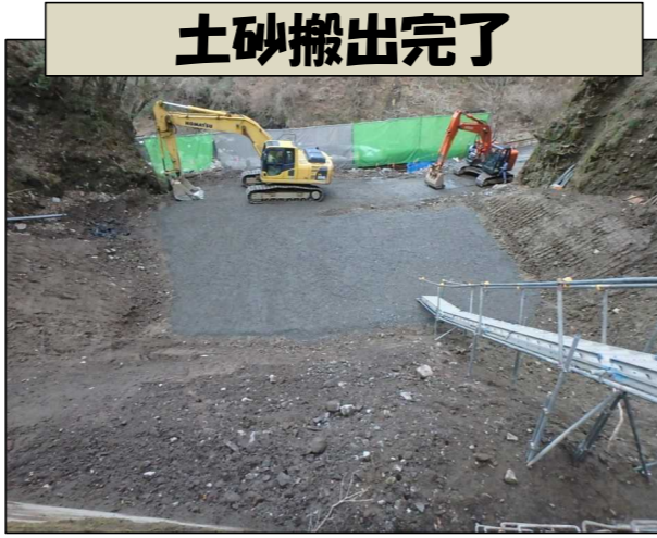
2月の工事状況
