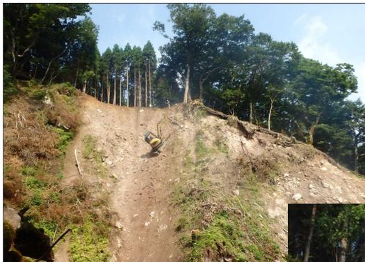
斜面の不安定な土砂を無人の重機で掻き落としている状況
