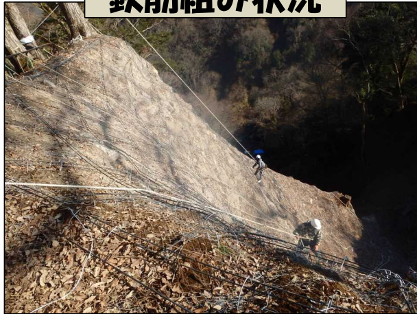
鉄筋組み状況
