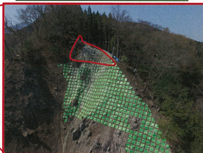
3月の工事状況
