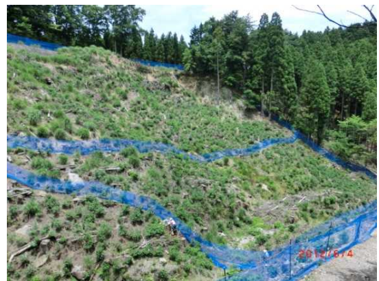
侵入防止柵の設置
