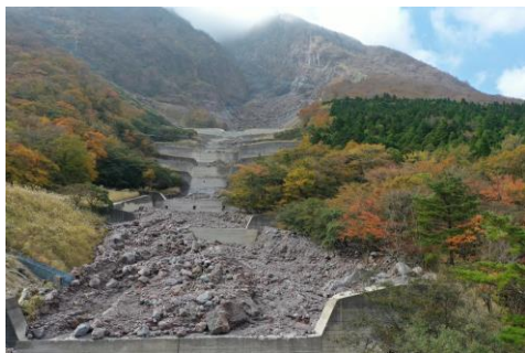
由布岳北側崩壊地治山工事箇所
