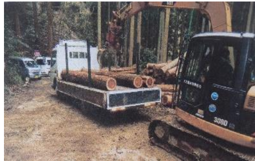
搬出した間伐材の積み込み作業 【白杵市】
