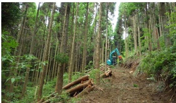
切土高を抑えた路網の作設 【竹田市】
