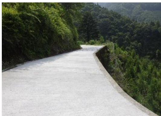
令和2年12月11日閣議決定された「防災・減災・国土強靱化のための5か年加速化対策」に基づき、人命・財産の被害を防止・最小化するための対策による林道改良(舗装)実施箇所(佐伯市 桑ノ原林道)
