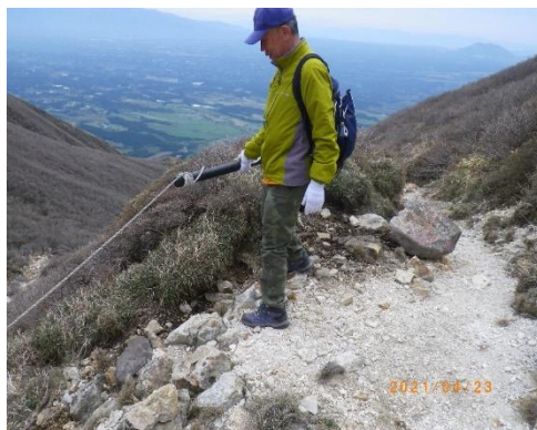
立入防止柵の簡易補修
