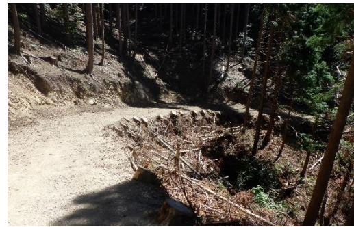
切り株を路肩補強に活用した路網の作設 【大分市】
