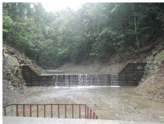
木製ダム(佐伯市宇目 切込国有林 H27完成)
