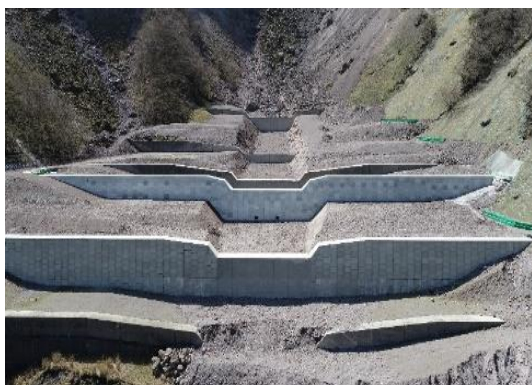
治山ダムを設置し下流への土砂流出を抑止するとともに林地の安定性を高めます。(由布鶴見岳国有林 12林班)
