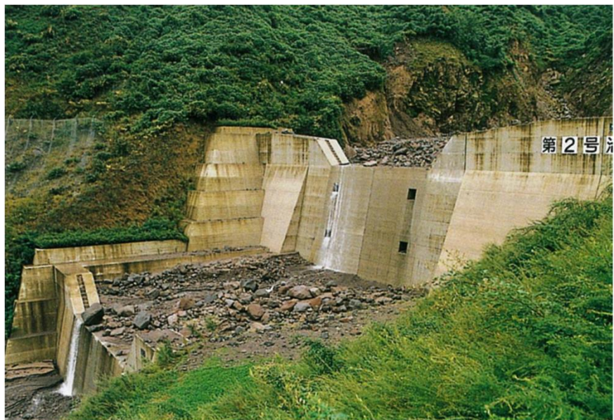
※治山ダムが有効に機能し 土砂を捕捉した状況
