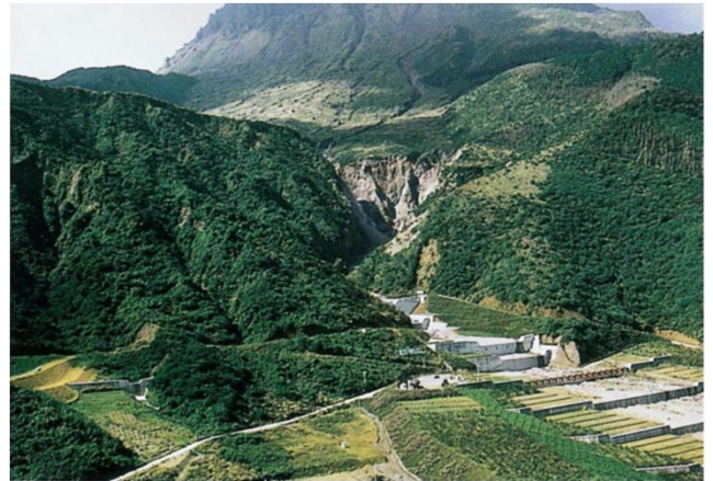
・治山施設の設置状況(中尾川流域)
