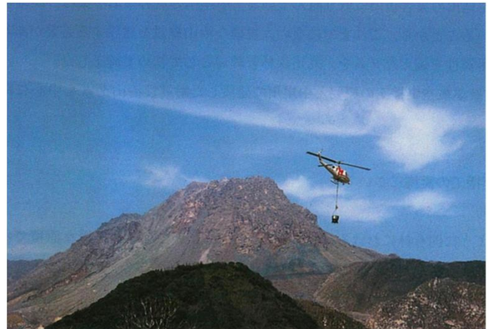
• 航空実播工の施工状況
