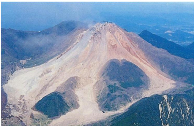
・火砕流により被害を受けた山腹斜面
