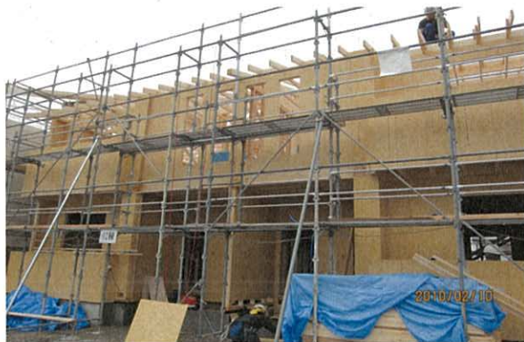
建設中の2×4住宅
