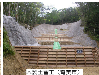
木製土留工（奄美市）
