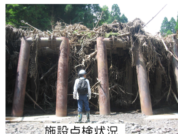
施設点検状況
