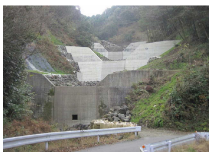
丸谷川流域に完成した治山ダム
