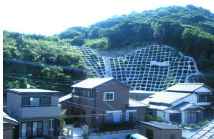
人家を守る山腹工（宗像市）
