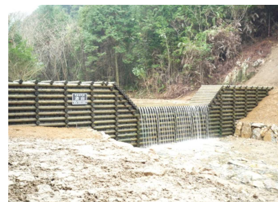
間伐材を使用した床固工（五島市）
