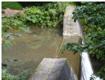
土石流センサー
