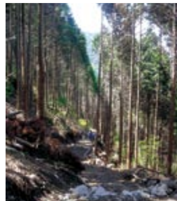
簡易で崩れにくい作業路網
