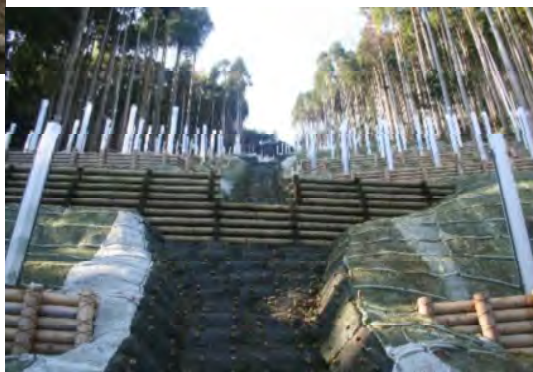
土留工完成時の状況
