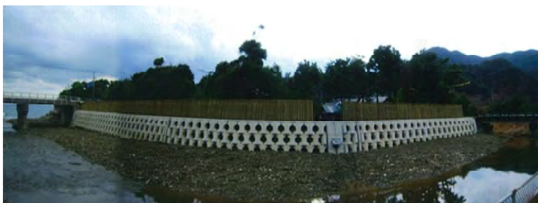
海岸護岸工の災害復旧後の状況
