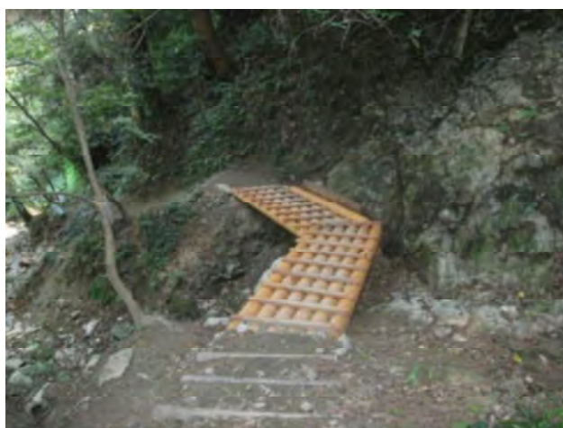
栈橋を新設し架け替えした様子
