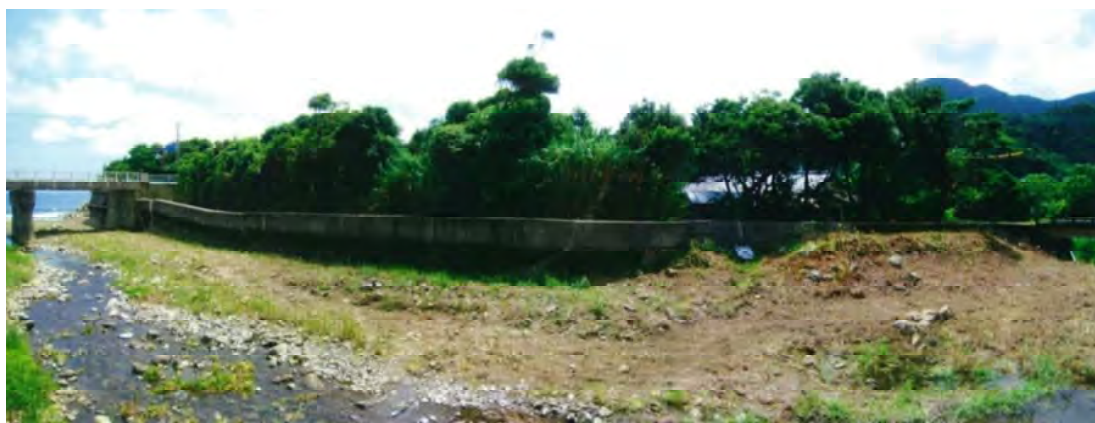
海岸護岸工の災害復旧前の状況
