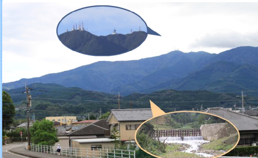
事務所から見上げた鰐塚山（上）山頂の様子・（下）治山工事堰堤
