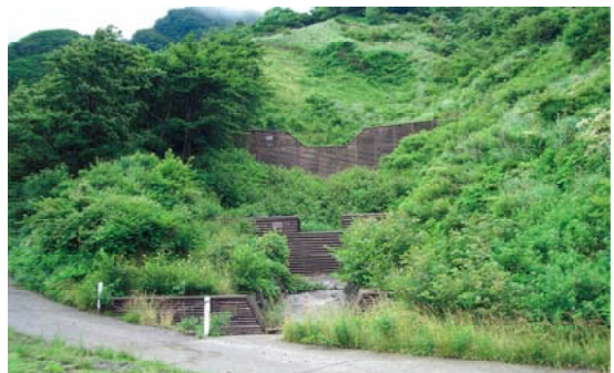
平成20年復旧状況（同上箇所）
