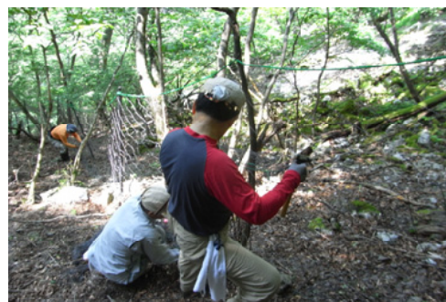
既設のネットにスカート設置＝宮崎北部
