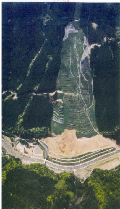
復旧完了後の状況
