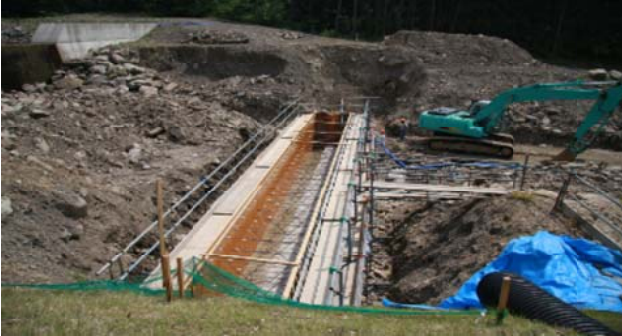
上：合板型枠の構成 中：合板型枠の組み立て状況 下：合板型枠の組み立て完了
