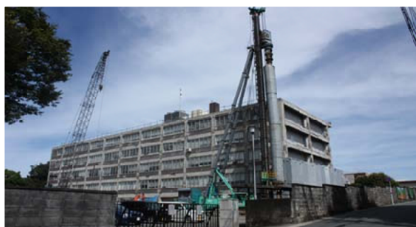
耐震改修工事中の局庁舎
