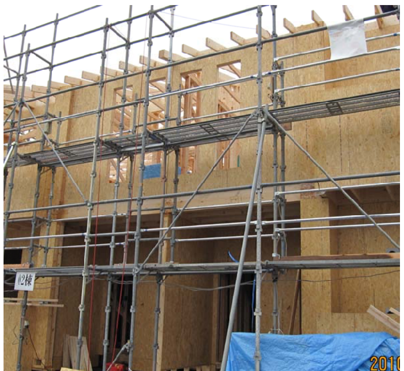
スギ材を部材に使用した2×4住宅
