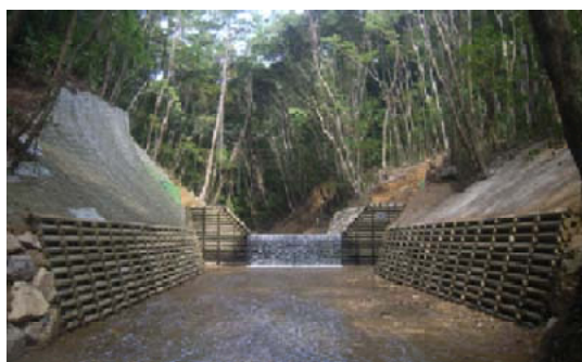
間伐材を使用した床固工等
