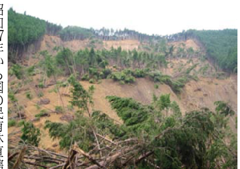
奈良県野迫村の山腹崩壊状況
