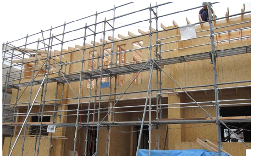
建設中の2×4住宅
