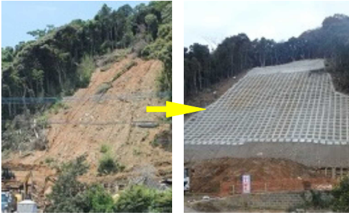
平成29年7月九州北部豪雨による崩壊地の復旧状況（朝倉市山後）
