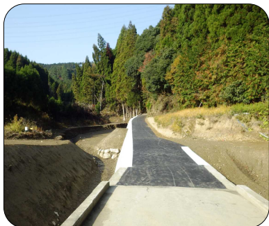
写真5 新山林道の復旧状況
