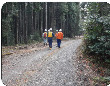
既設林道からの支線取付け確認
