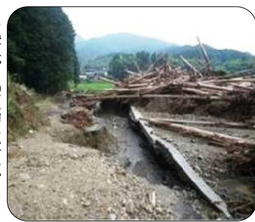
写真4 新山林道の被災状況
