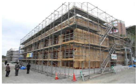
国産CLTで建設中のホテル（長崎県佐世保市）
