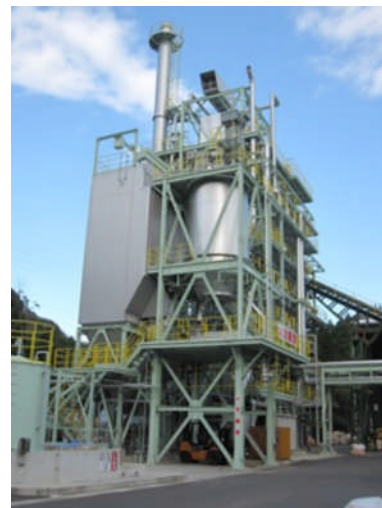
木質バイオマス発電所
