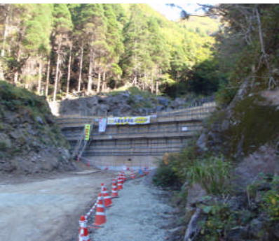
H27 猫岳治山工事 (熊本署)
