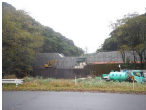
H27 荒襲治山工事 (都城支署)
