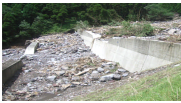
土石流を抑止した治山ダム
