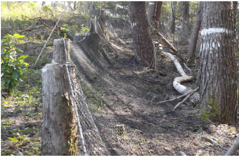
林縁木利用の斜め張り
