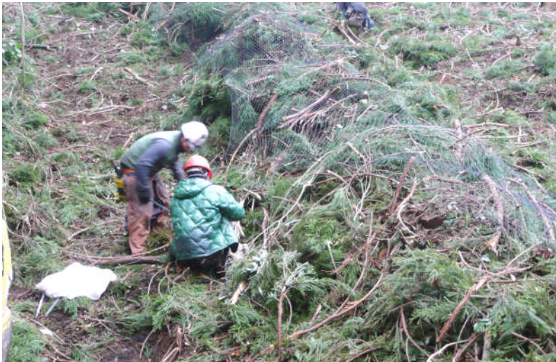
防護柵の寝かせ張り
