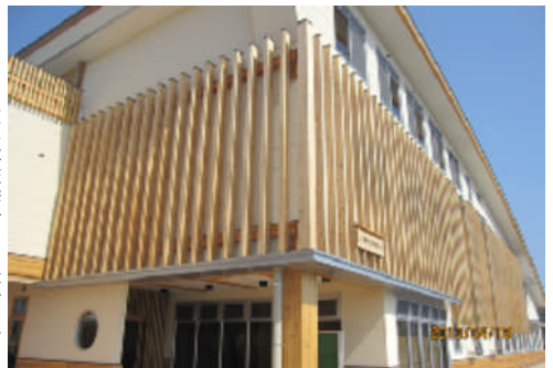
3階建て木造庁舎＝熊本県上天草市松島庁舎兼保健センター
