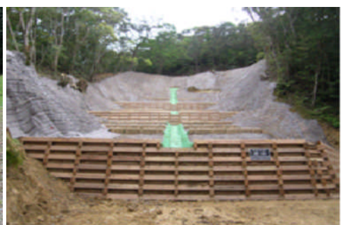
山腹工（鹿児島県奄美市）
