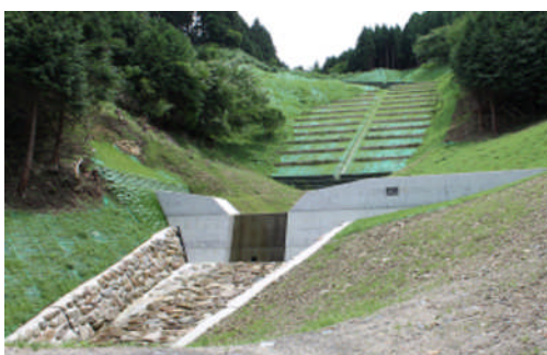
山腹工（福岡県嘉麻市）
