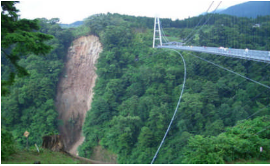
大分県九重町で発生した崩壊地
