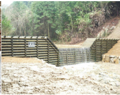
間伐材を使用した床固工（五島市）
