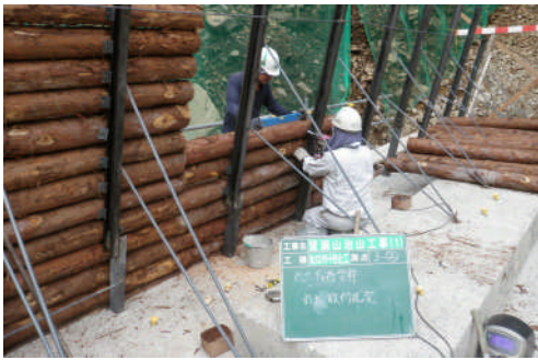
丸太残存型枠の施工状況
