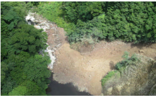
崩壊地の下部で発生した土砂ダム
