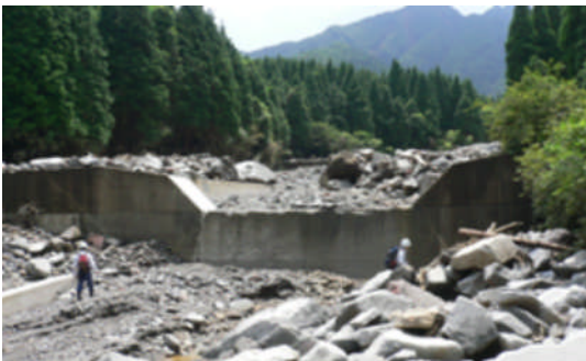
治山施設の点検調査状況
