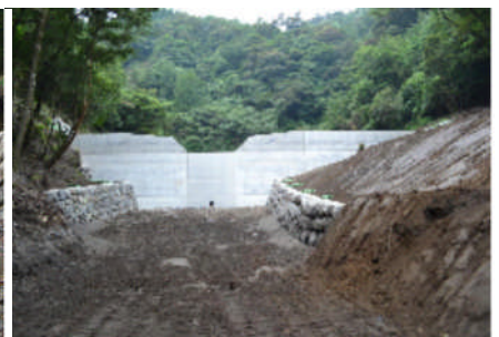
丸谷川流域に完成した治山ダム（都城市）
