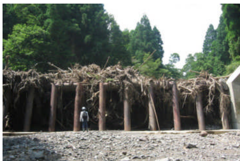
治山施設の点検調査状況
