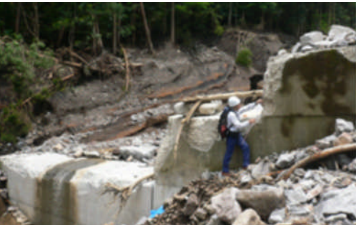
治山施設の点検調査状況
