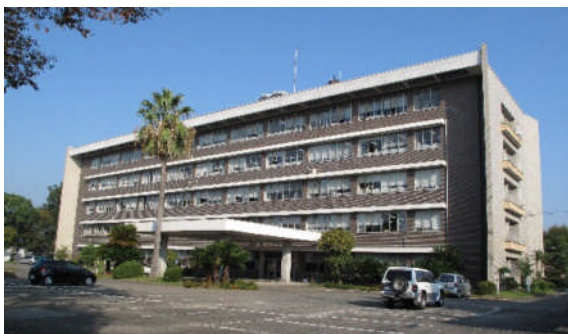
耐震工事着手前の旧庁舎
