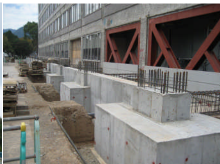
基礎工事の様子（平成22年10月）
