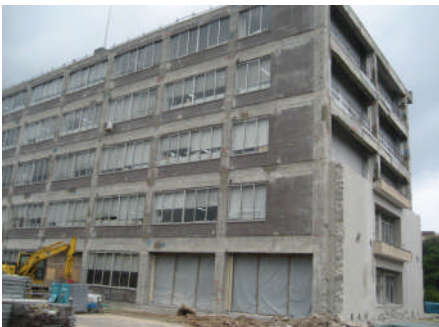
外壁改修工事の様子（平成22年8月）
