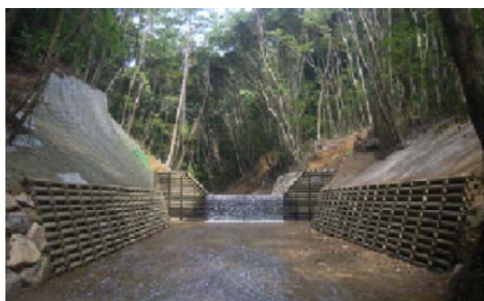
間伐材を使用した床固工等
