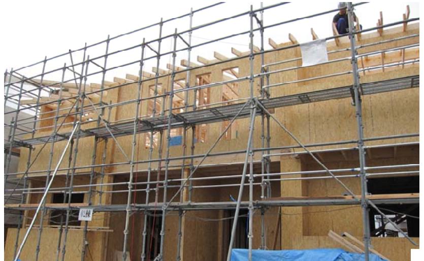
建設中の2×4住宅
