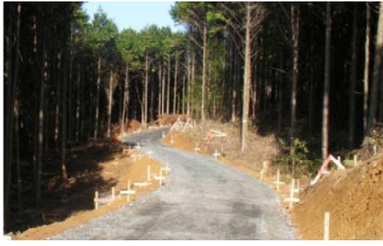
林業専用道モデル路線（開設工事中）＝熊本南部
