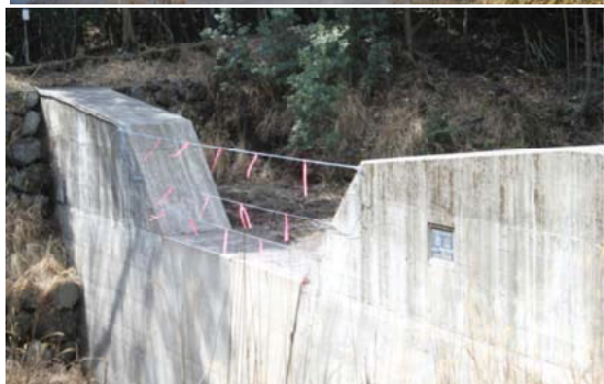
(上) 噴煙を上げる霧島山（新燃岳） (下) 治山施設に設置した土石流センサー
