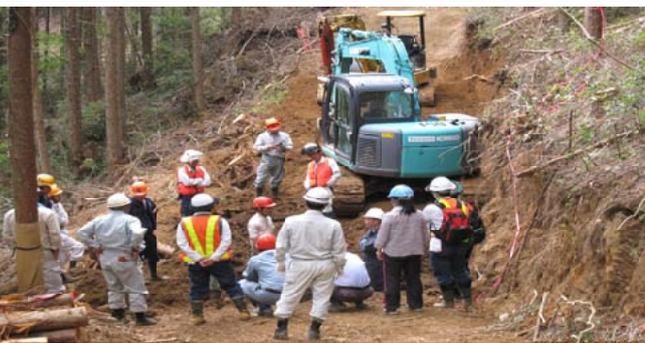
(上) 簡易で崩れにくい作業路で間伐材の搬出作業状況
