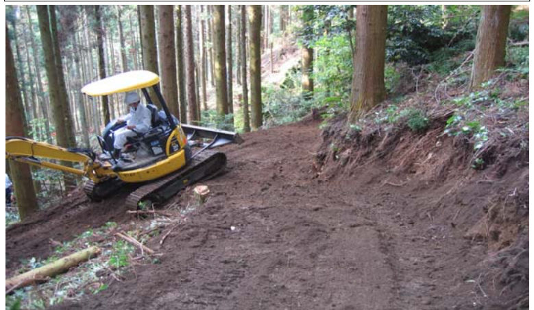
新スイッチバック作設状況
